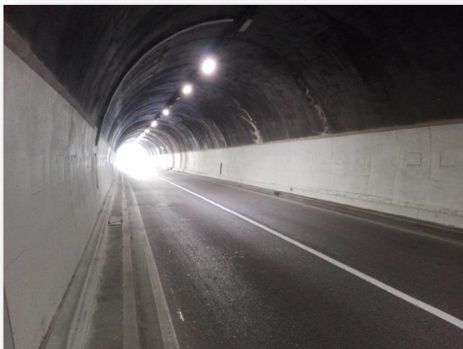
Тунел Будош, Черна гора
