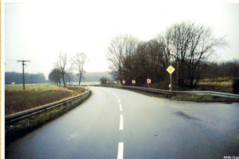
Bild 6: Beispiel für die Wirkung von Schutzeinrichtungen und Richtungstafeln sowie Geschwindigkeitsbeschränkung
